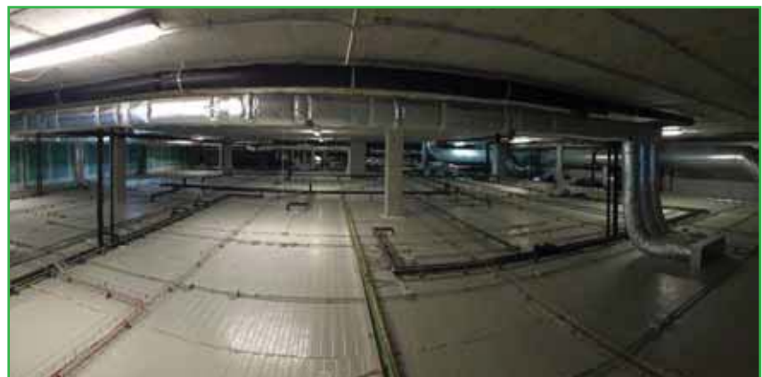
Fig. 4. Falso techo registrable
